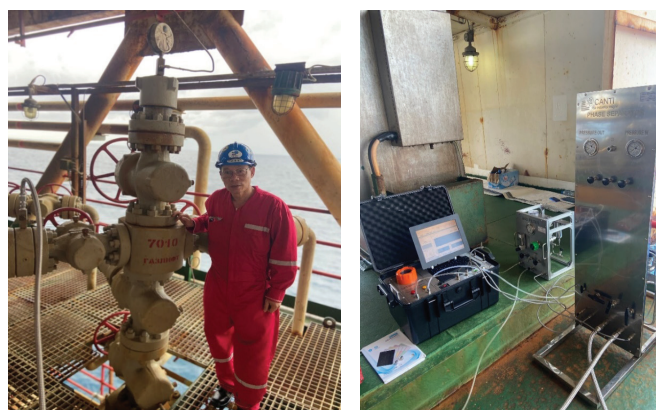
Hình 6. Thiết bị đo chất đánh dấu và vị trí lắp đặt thiết bị vào giếng gas-lift 7010.
