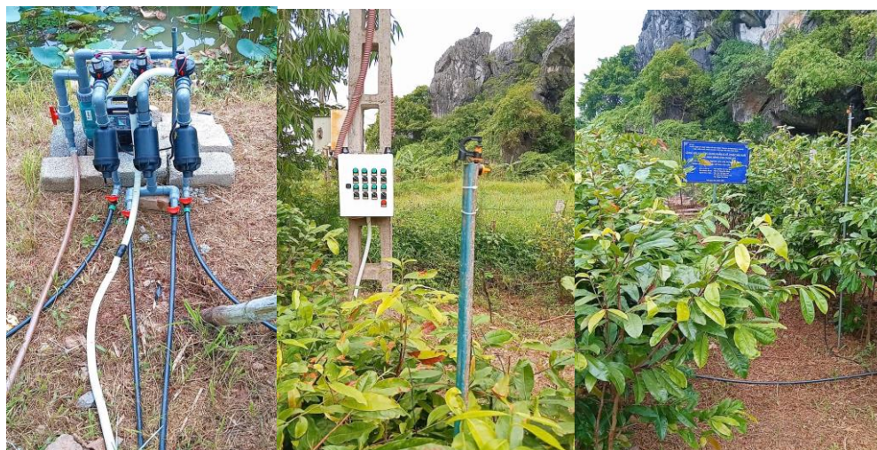
Hình 1. Hệ thống IOT và bố trí thí nghiệm.
