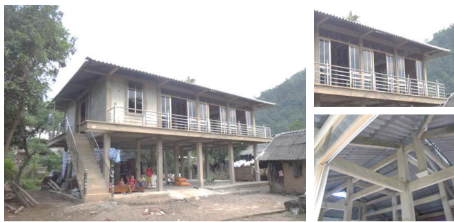
Hình 4: nhà người Thái tại bản Hóc - Văn Chấn (nhà khung bê tông, dầm khung bê tông theo kiểu khung nhà gỗ, lan can inox, mái lợp tôn)
