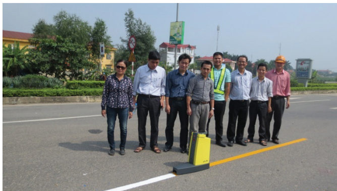
Vạch sơn polyurea (màu trắng) thử nghiệm tại Trạm thu phí Quốc lộ 2 (Vĩnh Phúc)
