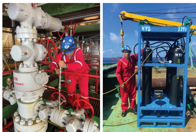
Hình 5. Lắp đặt và bơm chất đánh dấu vào giếng gas-lift 7010.
