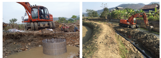
Hình 9. Thi công mô hình GTNM.
