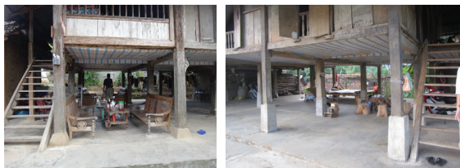
Hình 3: nhà ở tại Văn Chấn (trái) và Nghĩa Lộ (phải) (gầm sàn đã được sử dụng như một không gian sinh hoạt, bạt nhựa che dưới trần tránh bụi rơi từ sàn trên)
