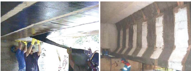
Hình 2. Hình ảnh gia cường kết cấu chịu uốn bằng CFRP [1].
