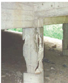
Hình 1. Hình ảnh hư hỏng trên kết cấu BTCT.
