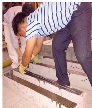
B- Thi công dán tấm CFRP.
